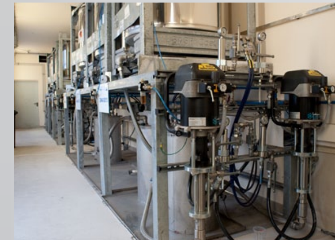
Containerversorgung aus 1000l-Containern mit Zwischenbehälter Container supply system with 1000l-containers incl. surge tanks
